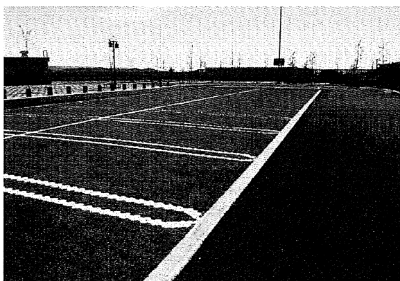
図3 ターフパーキング施工事例
