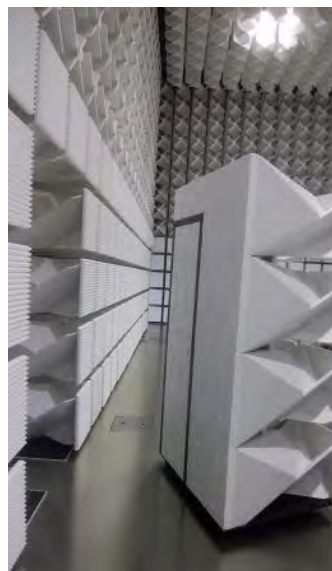
電波暗室内部
