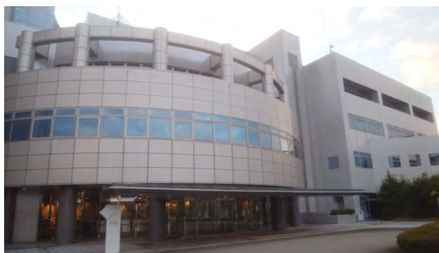
大阪産業技術研究所 和泉センター正面玄関
